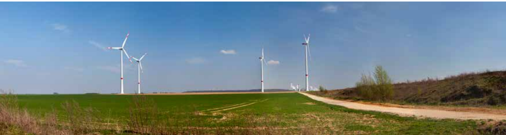
Windpark Jüchen 4 x 3,4 MW Repower
