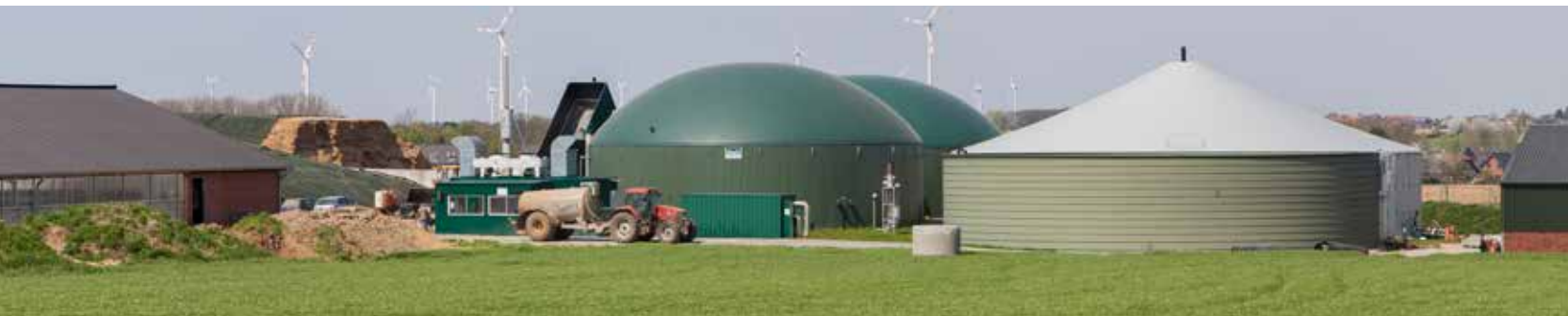
Biogasanlage Gangelt 2 x 265 kW el
